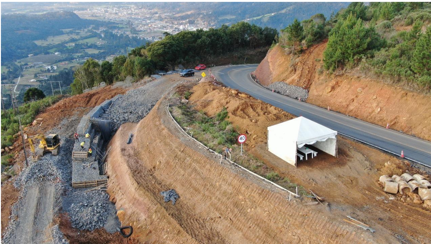
Obra Emergencial SC-110 Urubici - São Joaquim
