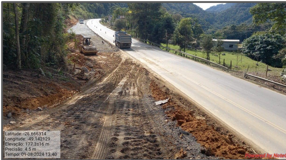
Ampliação da plataforma km 97
