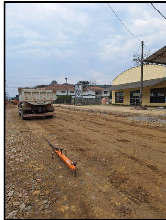
Regularização de subleito
