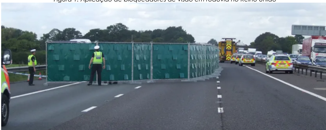
Figura 1: Aplicação de bloqueadores de visão em rodovia no Reino Unido
