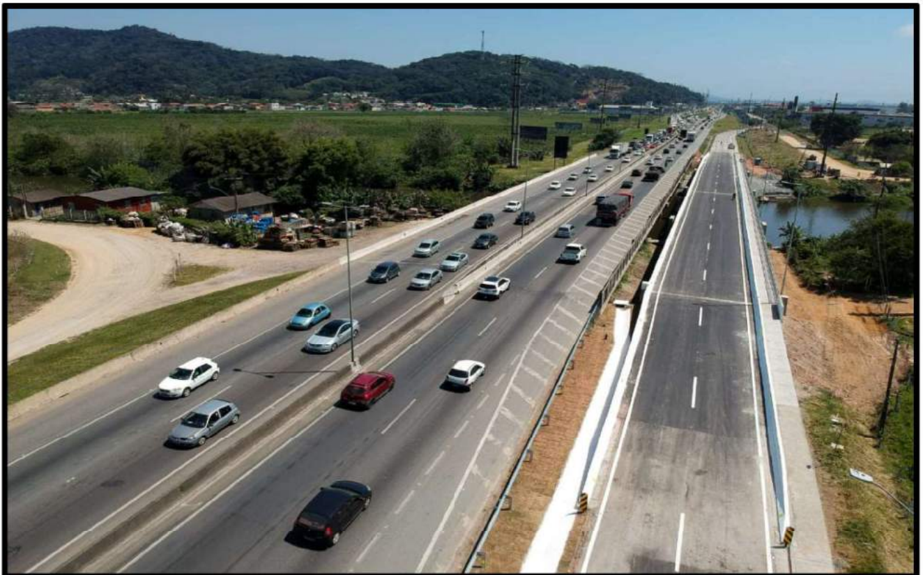
Imagem 6.2 - Ponte sobre o Canal Itajaí-Mirim - Marginal Norte
