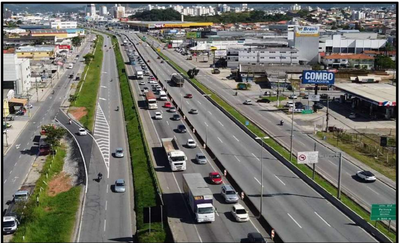
Imagem 6.3 - Faixa Adicional (Terceira Faixa) na Grande Florianópolis – Sentido Sul
