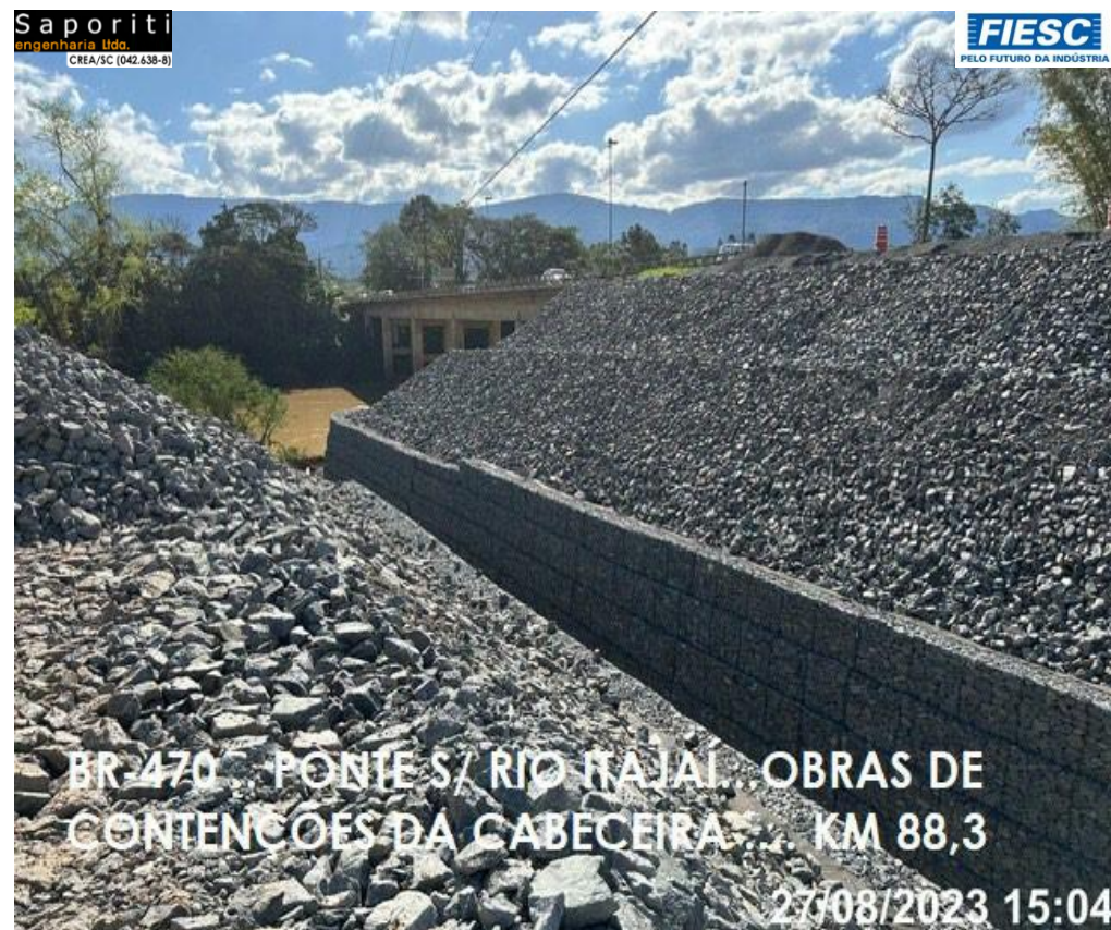
IMAGEM: BR-470 PONTE S/ RIO ITAJAÍ – OBRAS DE CONTEÇÕES DA CABECEIRA – KM 88,3
