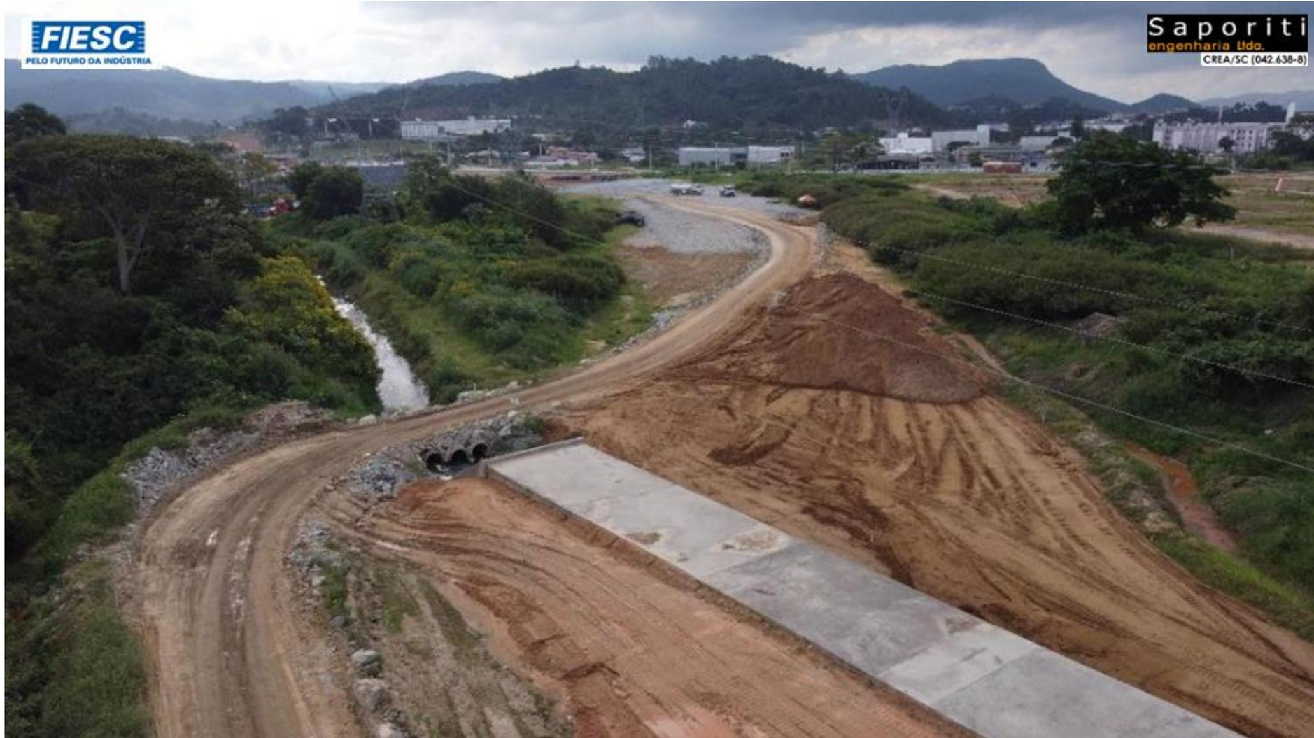
**28:** PASSAGEM INFERIOR NO KM 231+900 – Região de solos moles, onde foram utilizados drenos verticais a cada 1,5 metros, e posteriormente aterro com sobre carga para adensamento.
