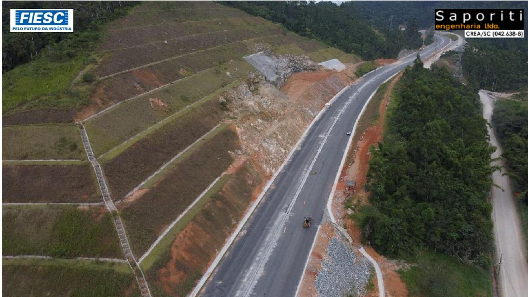
**9:** CORTE "CAIXÃO" COM PROTEÇÕES DE ENCOSTAS ATIRANTADAS – Idem acima.
