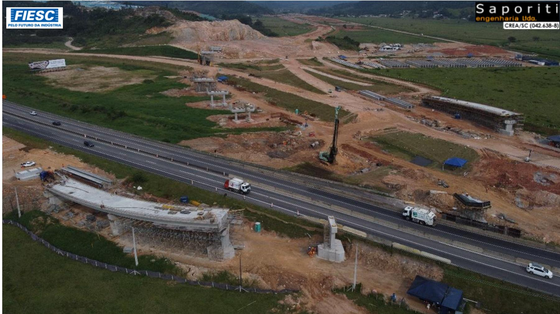
**2:** VIGAS LONGARINAS FABRICADAS, a serem lançadas nos viadutos em execuções no segmento do Trevo Norte.
