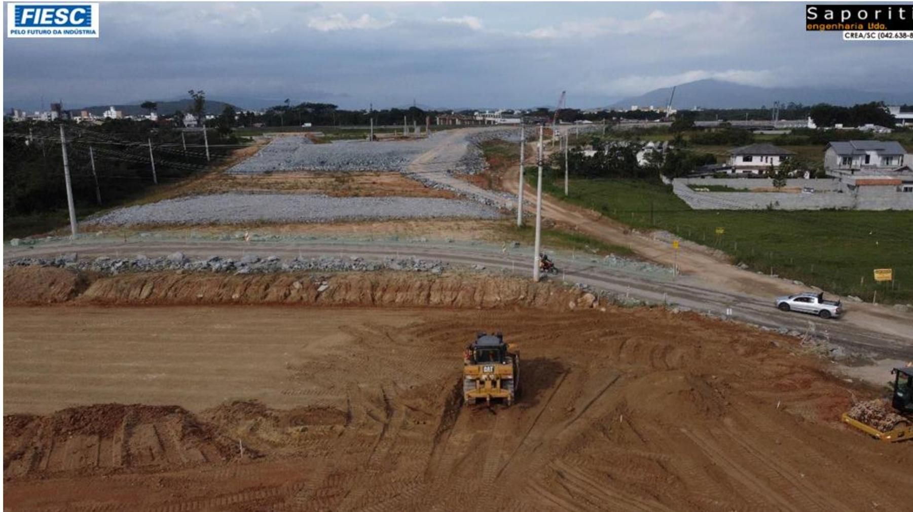
**29:** RECALQUES DE ATERROS (MONITORAMENTO) – KM 232+500 – Ao fundo, a interseção com a BR-101 (Sul).
