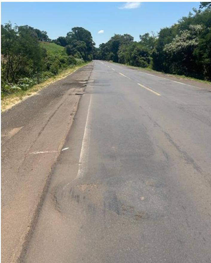
3.1.2.4- Trincamento e desagregação do pavimento no km 122.
