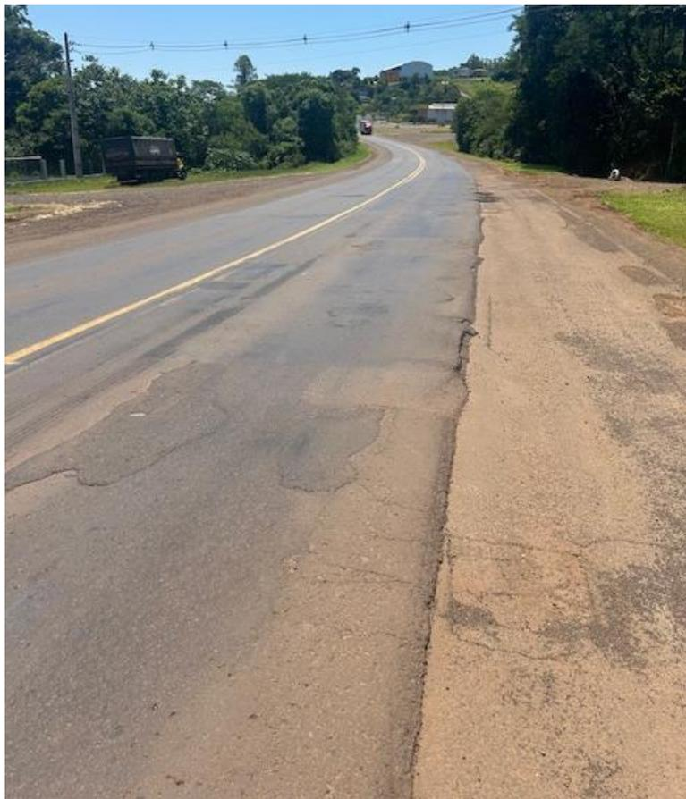
3.1.2.2 - Buracos, afundamento e recalque do pavimento no km. 111,5 o que se repete ao longo de 900 metros.
