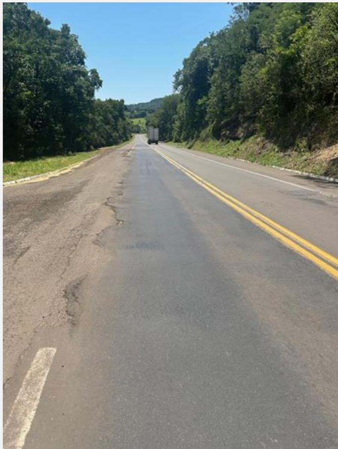
3.1.2.6- Buracos, afundamentos e recalque do pavimento - km 122.
