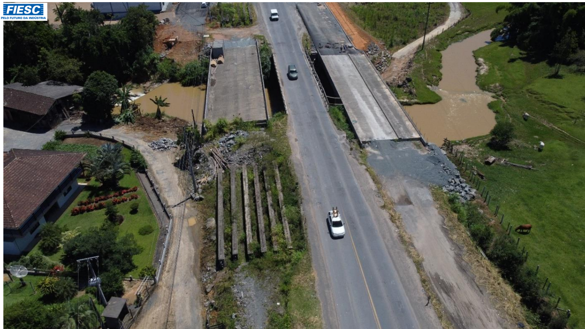
35: PONTES EM EXECUÇÃO SOBRE O RIBEIRÃO ESTRADINHA
