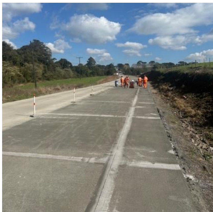
16 – Execução das juntas de dilatação no km 26,00
