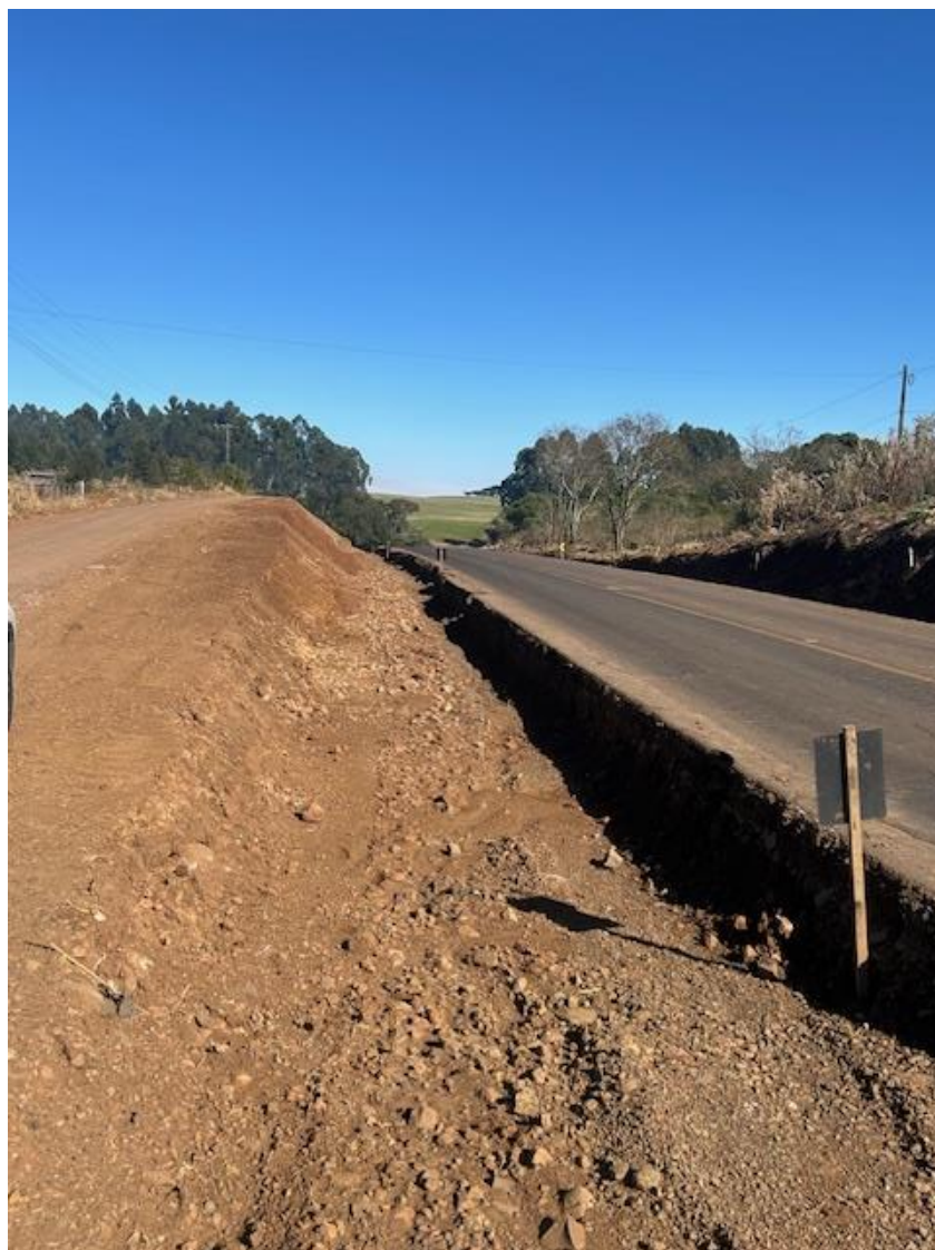
25 – Obras no km 70,00 (em andamento)
