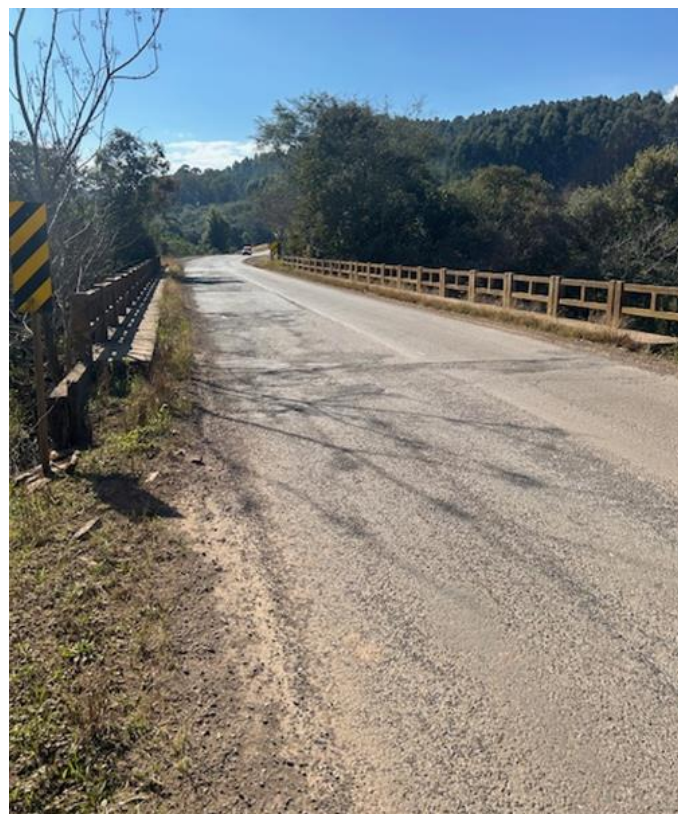
3 – Situação da ponte existente no km 6,20
