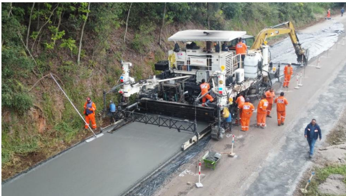
10 – Execução do pavimento em concreto. (Foto divulgação)
