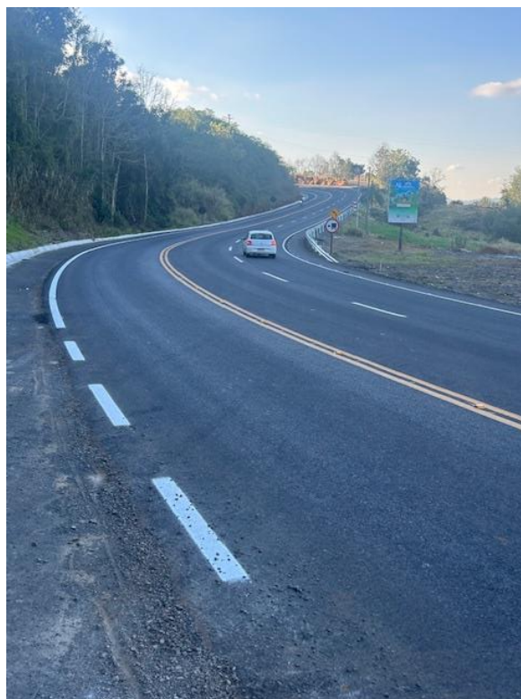
20 – Subtrecho Palmitos/São Carlos – Pavimento já restaurado
