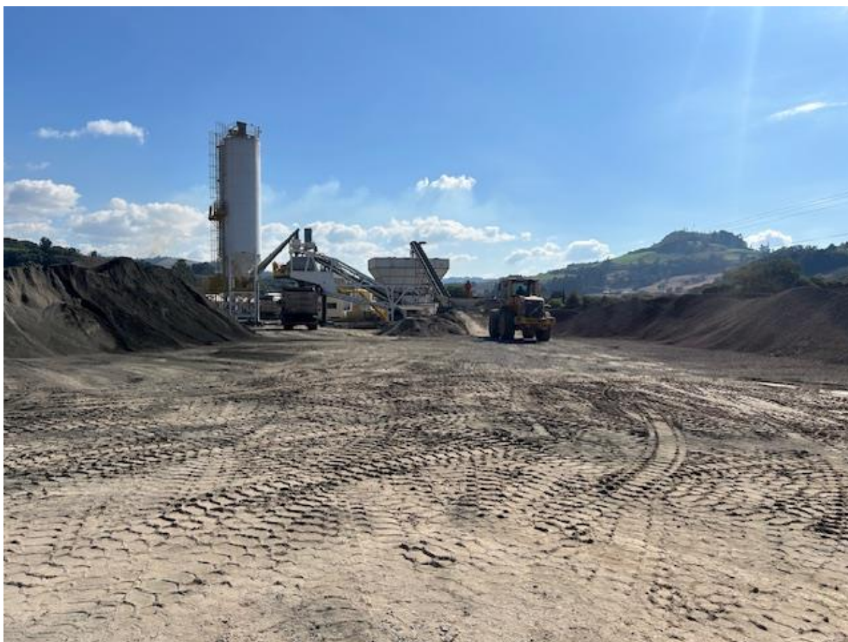
11 – Usina de concreto – km 16,00
