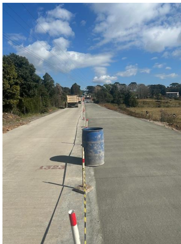
15 – Pista em concretagem no km 26,50
