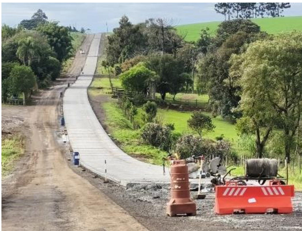
13 – Meia pista com pavimento concretado. (Foto Divulgação)
