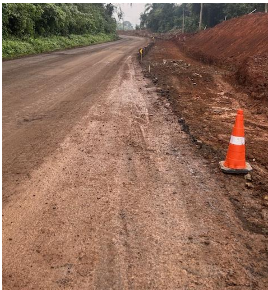
23 – Alargamento da pista no km 75,00 (obras em andamento)
