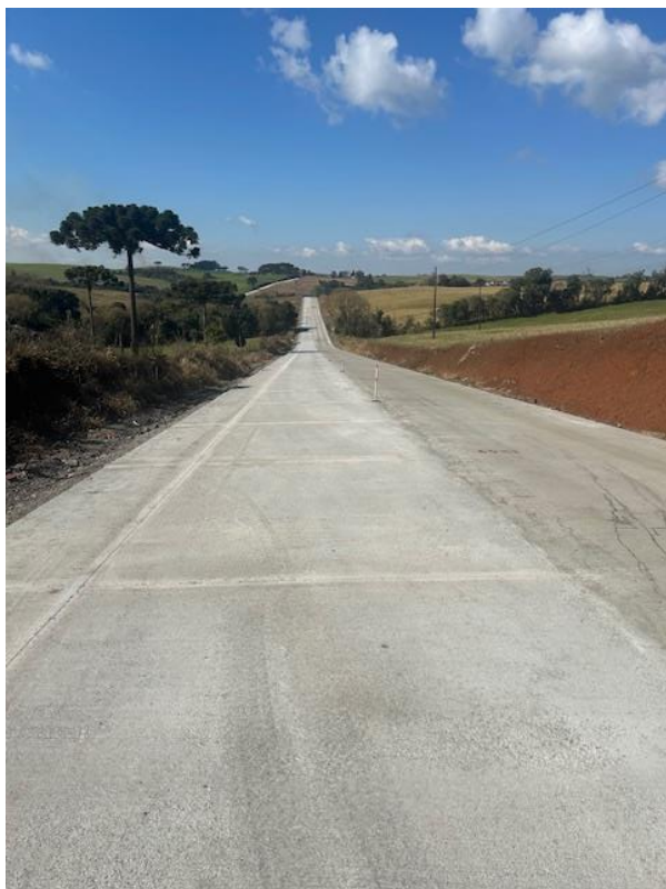
14 – Vista parcial da pista no km 24,10
