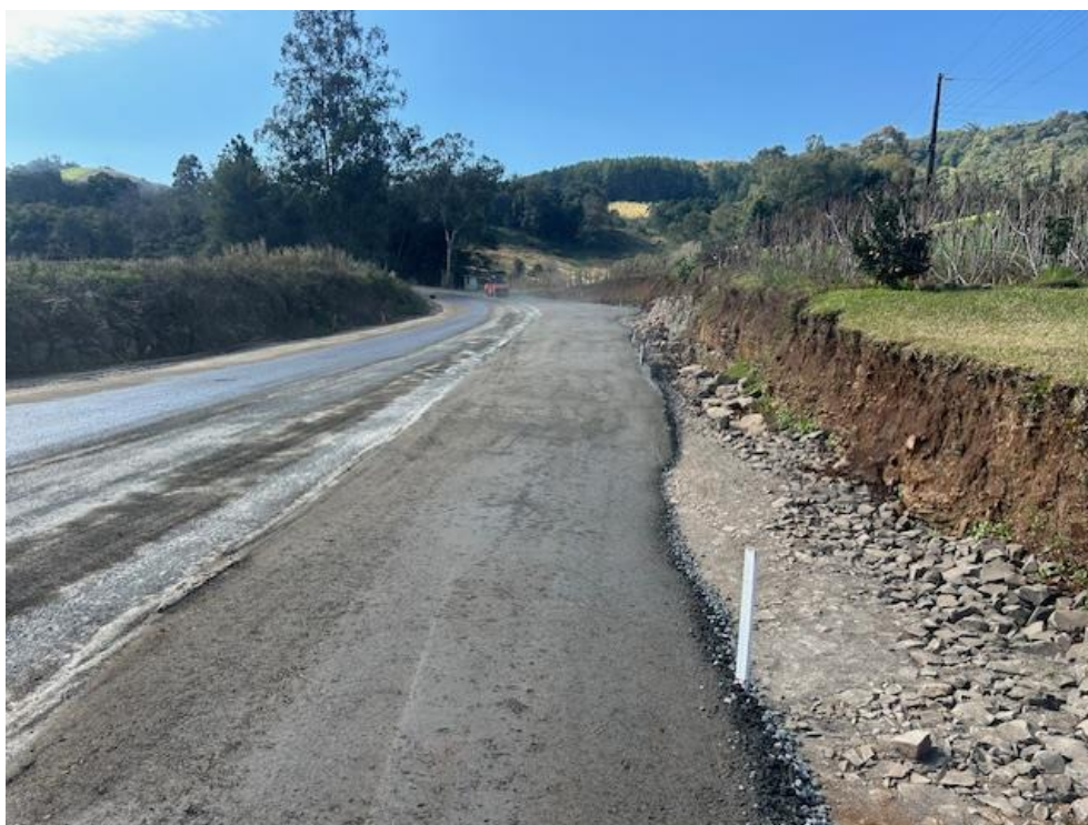
8 – Conclusão da base da 3ª faixa no km 14,00
