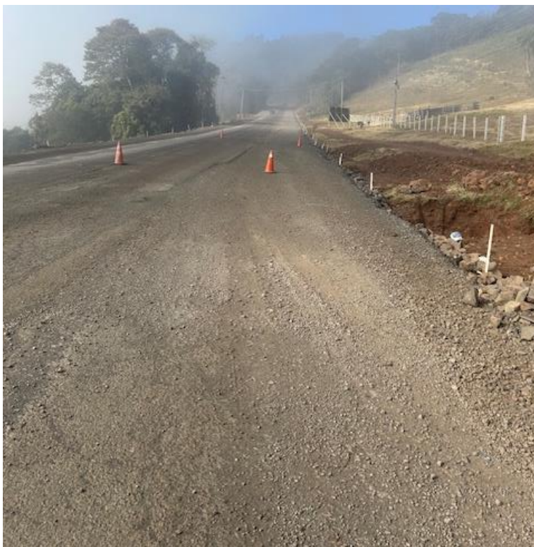
29 – Execução do pavimento p/ 3ª faixa no km 58,00
