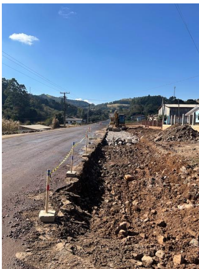
9 – Base em execução da 3ª faixa – Três Voltas (km-15,20)
