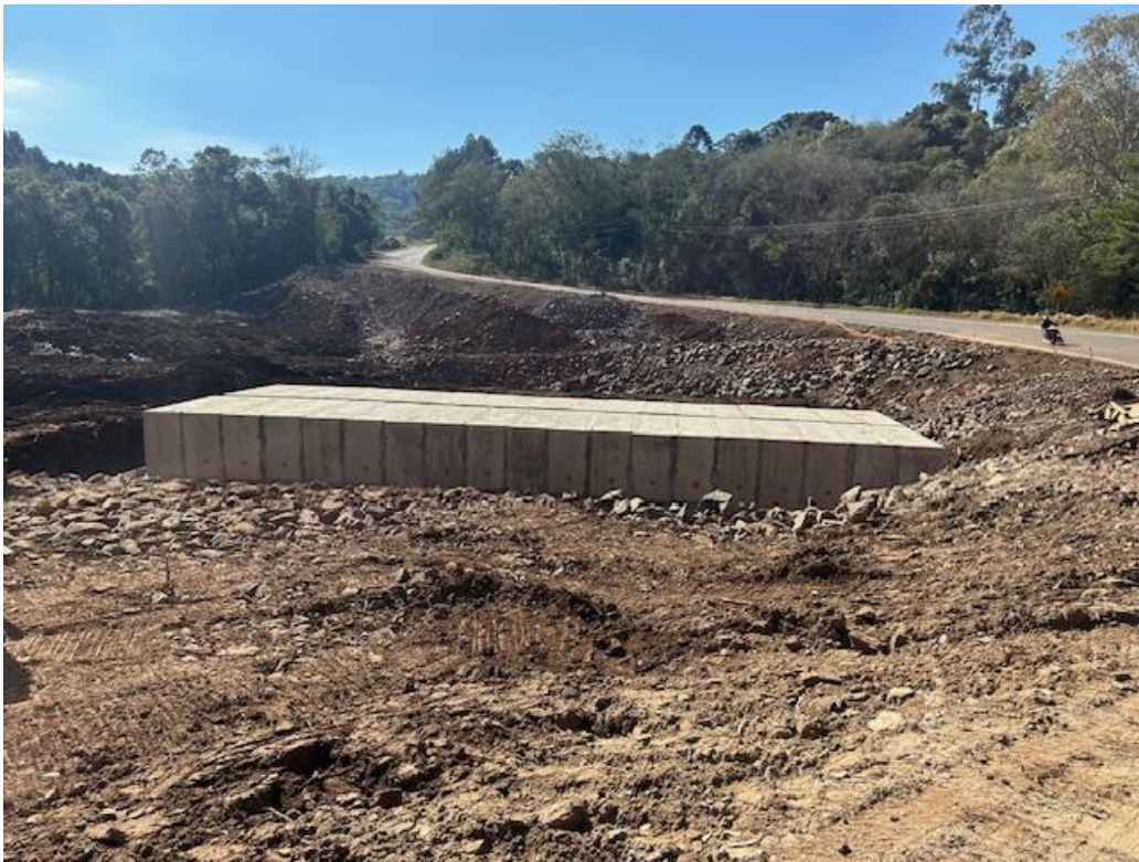
6 – Canalização de córrego no km 10,70
