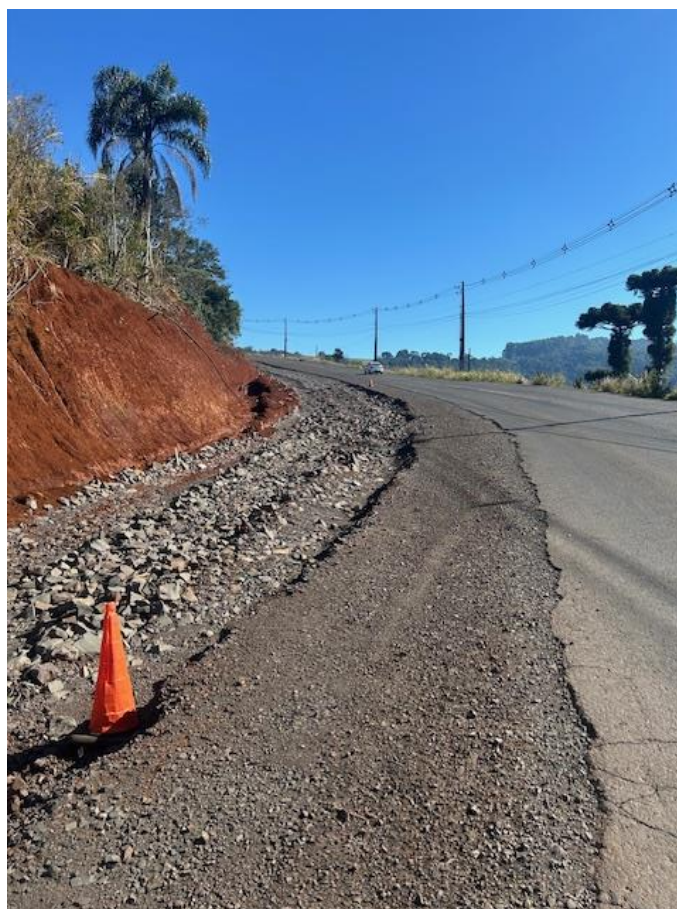
30 – Obras no km 52,00
