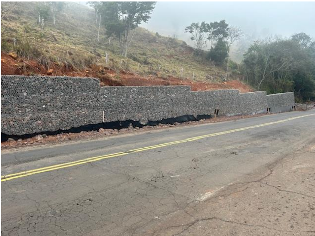
26 – Contenção executada no km 61,00
