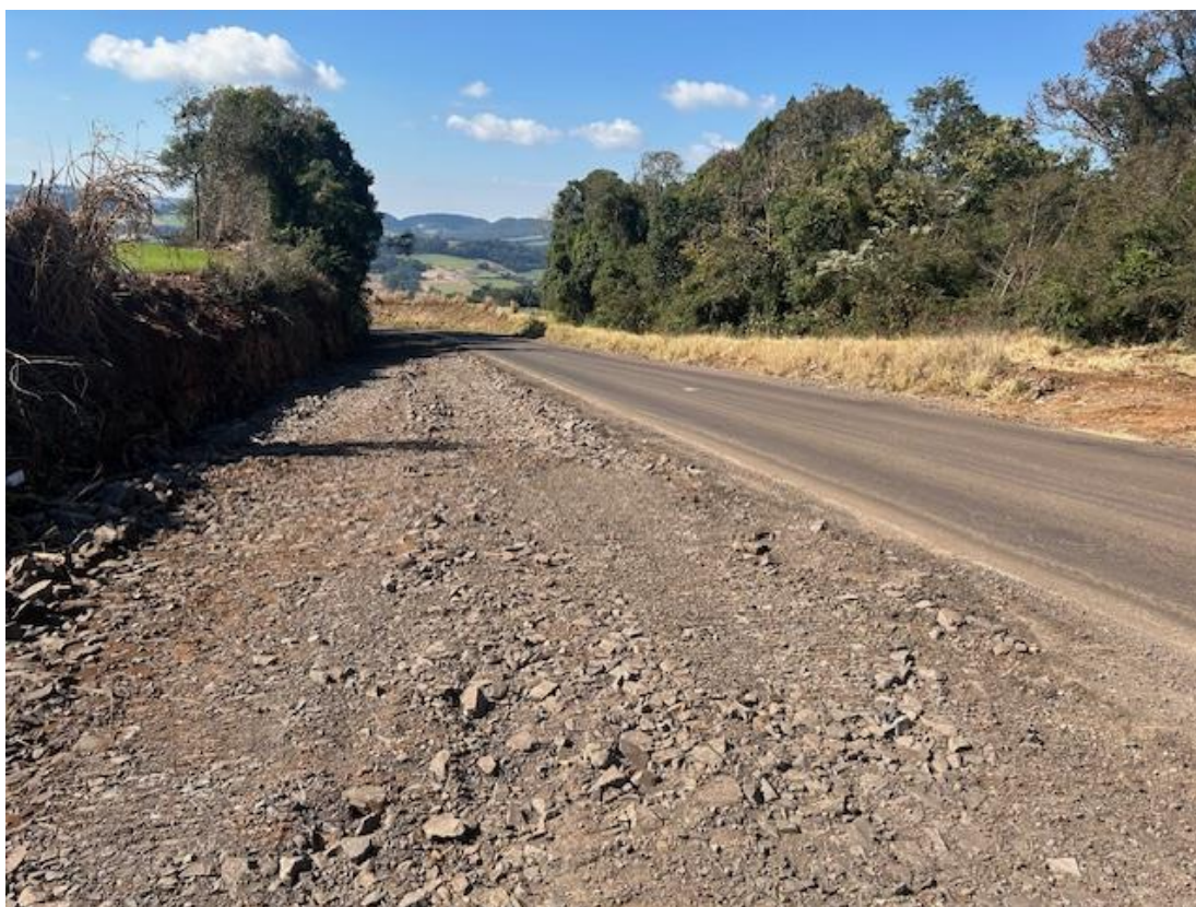
5 – Base em execução da 3ª faixa – km 8,20
