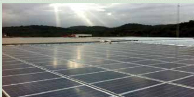
Panorama da fábrica de motores (no alto), jardins filtrantes e módulos fotovoltaicos: LEED categoria ouro
