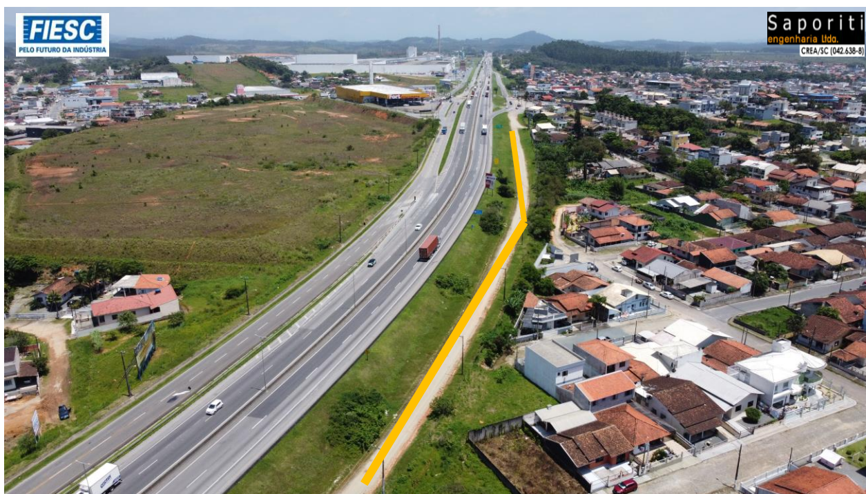
15: Implantação e pavimentação de Rua Marginal, entre kms 86,5 e 87,4 (Sentido Norte) - Barra Velha.
