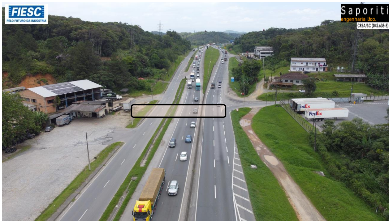
13: Implantação de Passarela no km 47,7 (Joinville)
