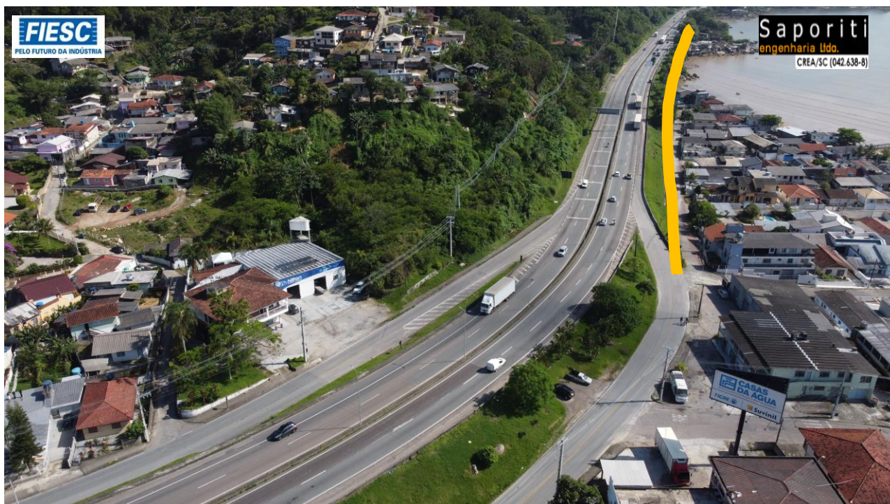
25: Implantação e Pavimentação de Rua Marginal entre kms 193,2 e 192,3
