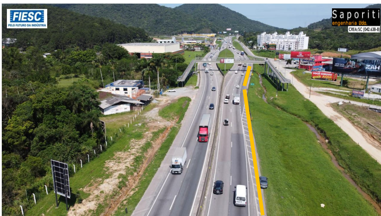
19: Implantação de 3ª faixa, sentido sul, entre os kms 128 e 135 - Sentido Sul
