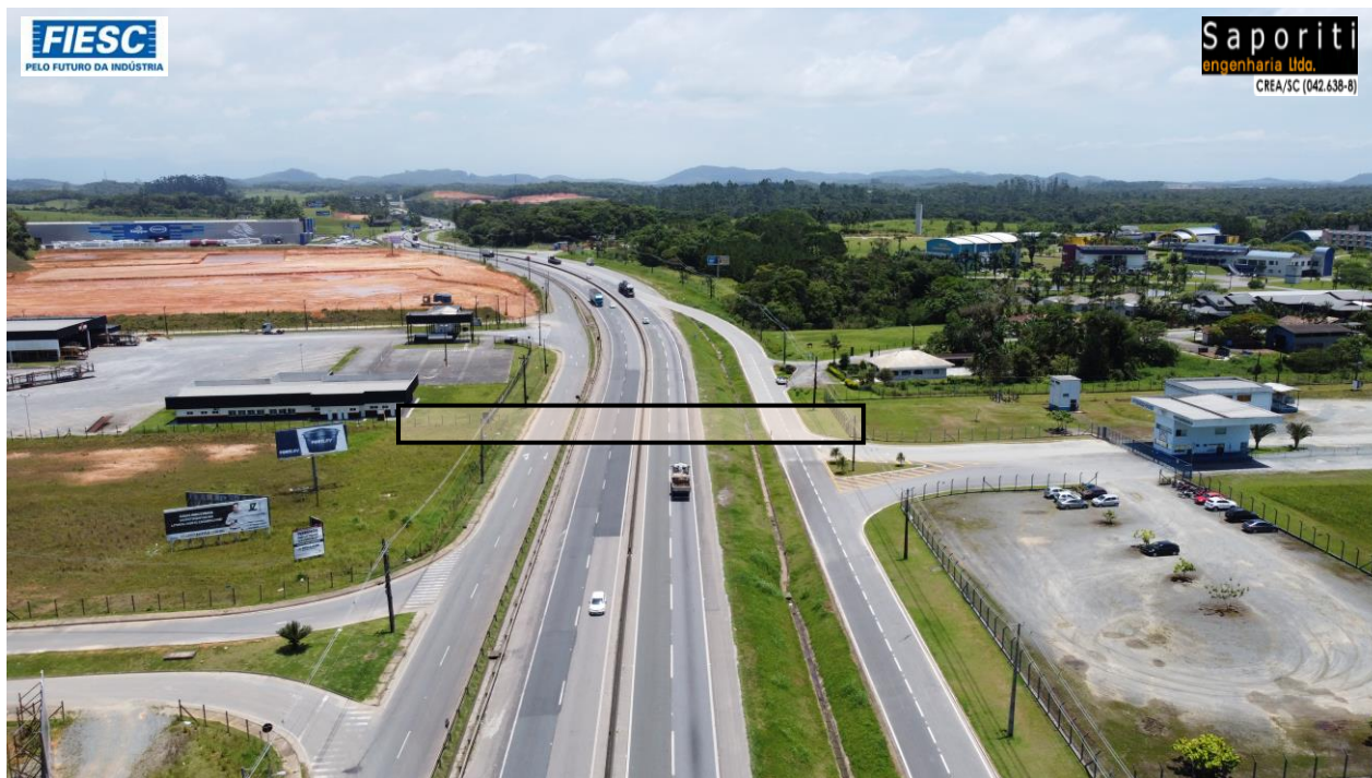
12: Implantação de Passarela no km 64 (Araquari)
