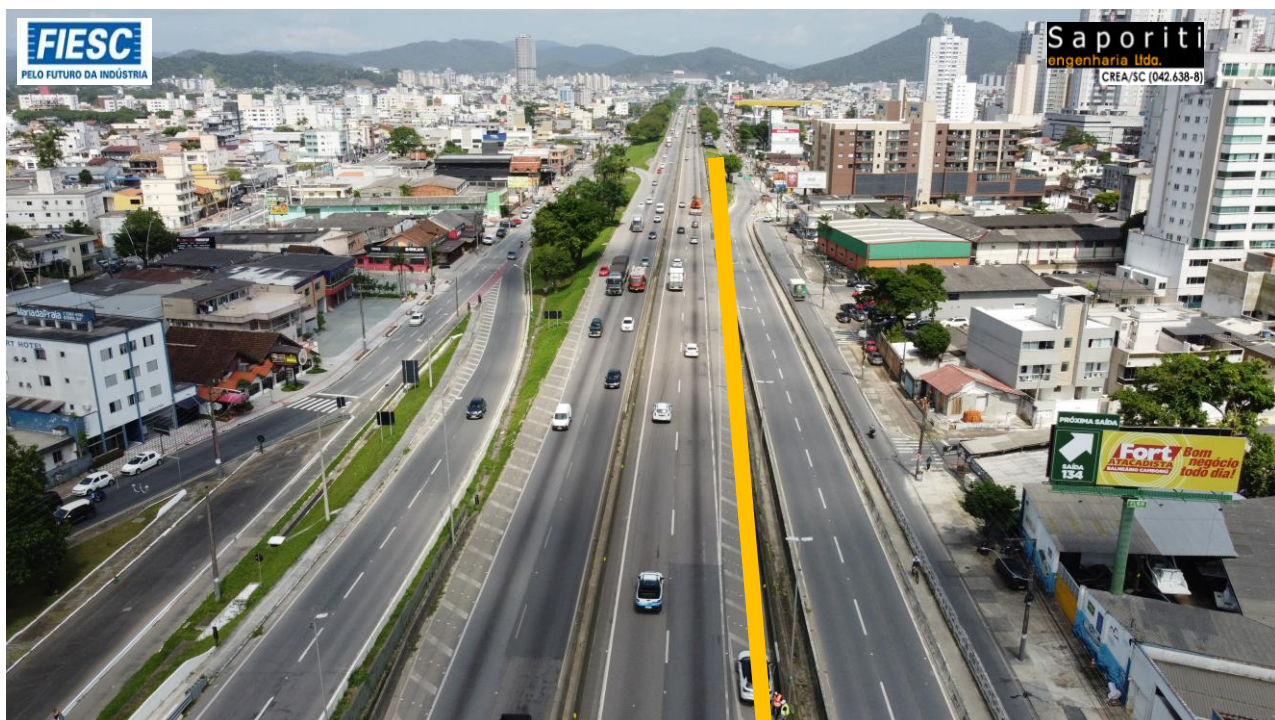
21: Execução de 3ª faixa - Pista Sul - entre kms 128 e 135
