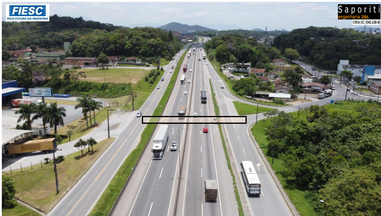
10: Implantação de Passarela no km 44,3 (Joinville)
