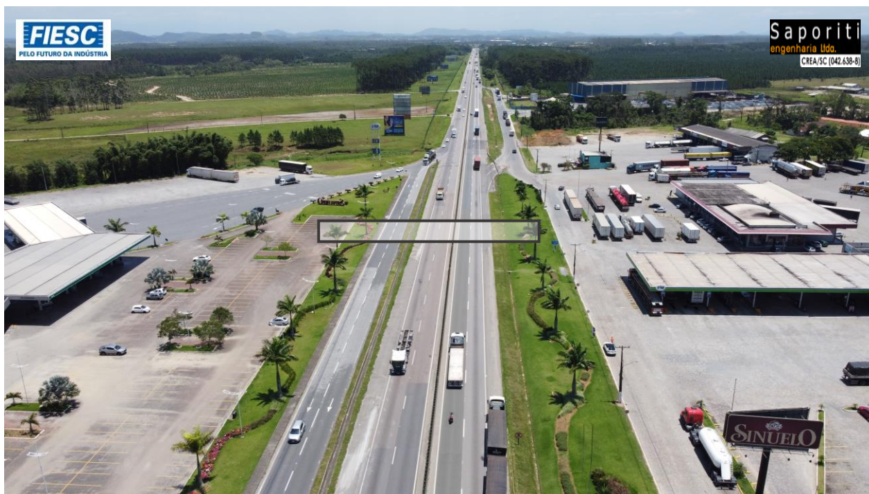
14: Implantação de Passarela no km 70,8 (Araquari)
