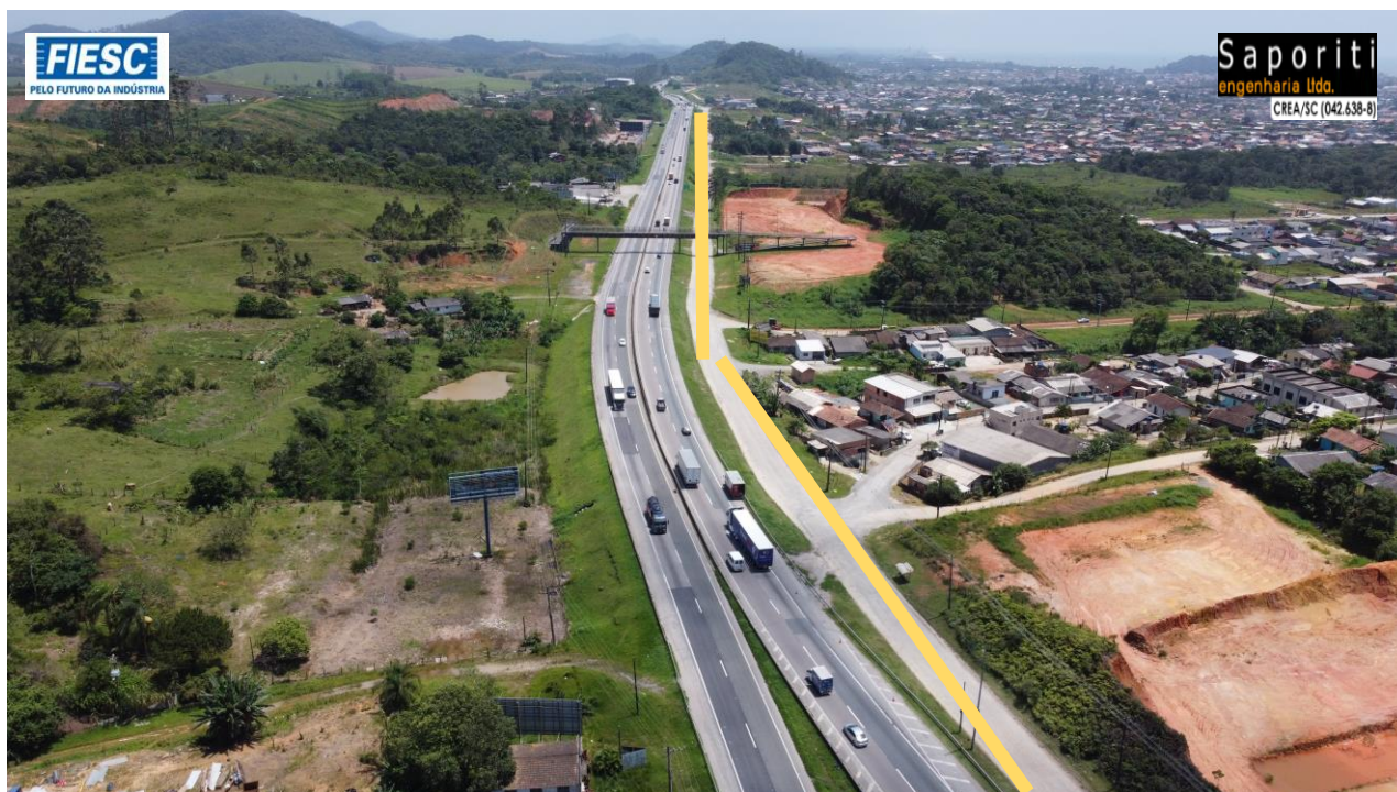
16: Implantação e pavimentação de via marginal entre kms 95,5 e 97,8- Bal. Piçarras - Sentido Norte
