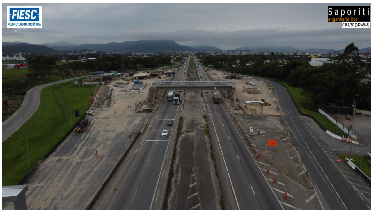
8 : Km 219,4 - Implantação das Instalações de Descanso dos Caminhoneiros
