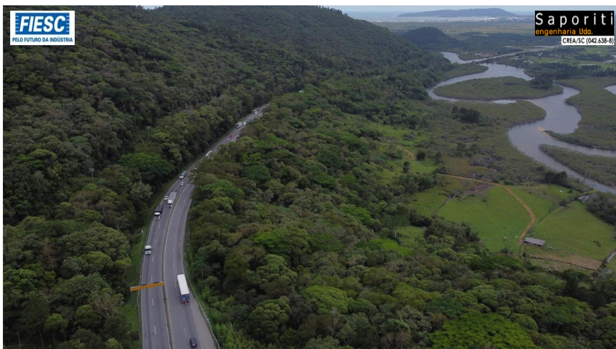
29: Morro dos Cavalos – Ao fundo, Ponte sobre o Rio Cambirela (Km 234,8)
