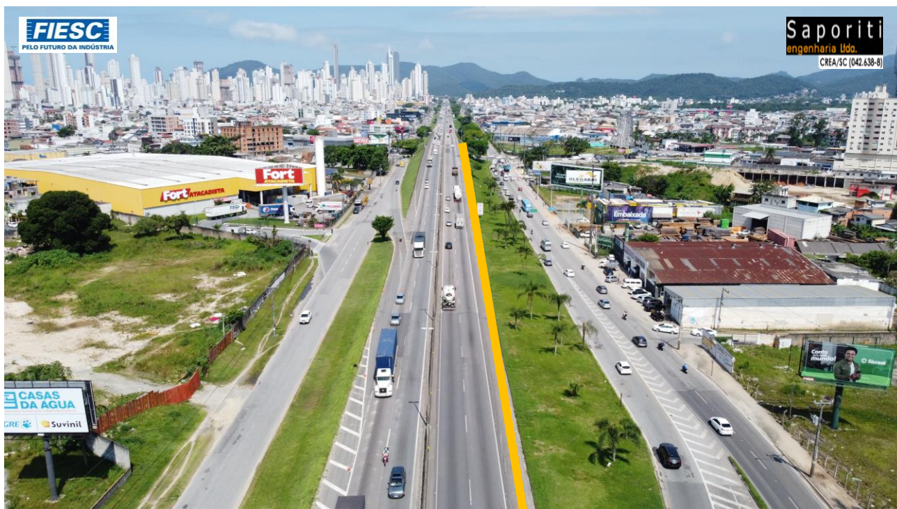
20: Implantação e pavimentação da 3ª faixa - (kms 128 ao 135) – Sul
