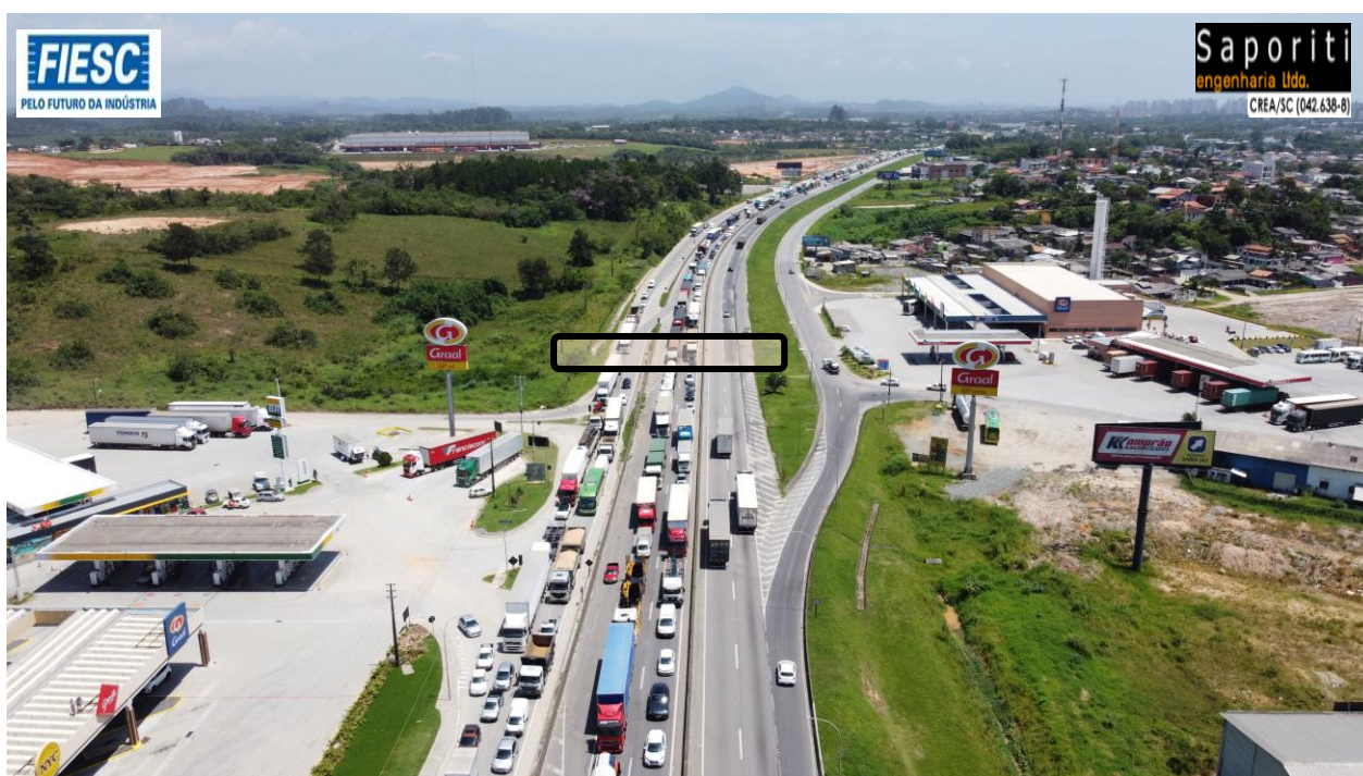
17: Implantação de Passarela no km 102,5 - Balneário Piçarras
