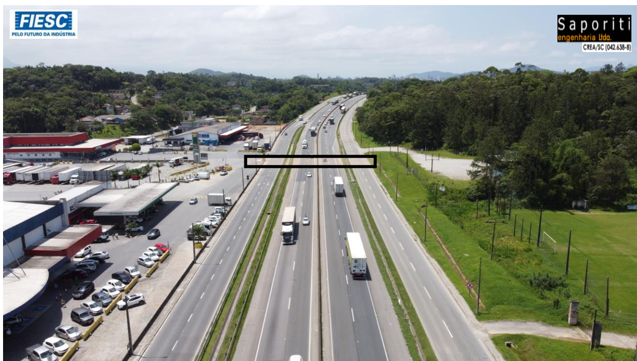
11: Implantação de Passarela no km 46 (Joinville)
