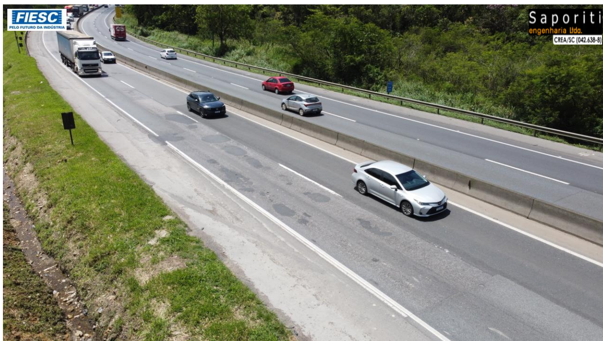
6: Km 55 - Buracos, trincamentos e desagregação do pavimento - Pista Sul
