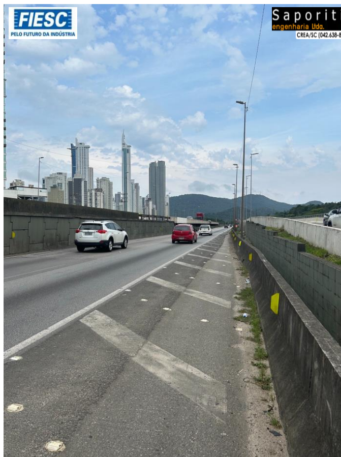
22: Soerguimento da Ponte sobre o Rio Camboriú (km 135,7)
