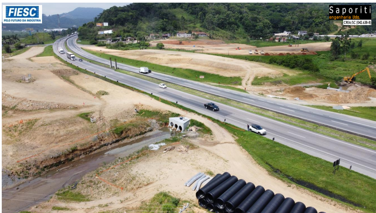
7: Km 108,3 - Implantação de dispositivo de retorno - Obras em execução
