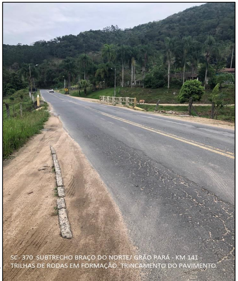
SC-370 – sub trecho Braço do Norte/Grão Pará – KM 141 Trilhas de rodas em formação e trincamento do pavimento
