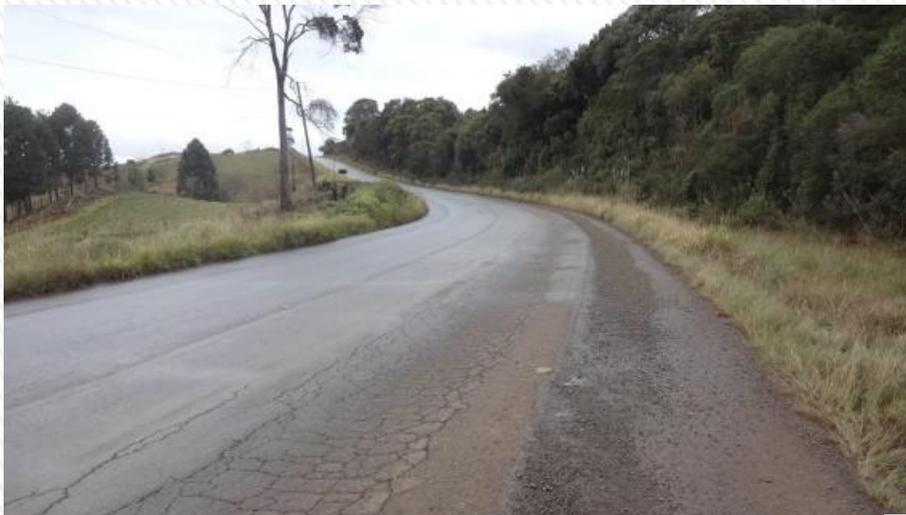
TRECHO MATOS COSTA/ CALMON - KM 74,5 - TRILHA DE RODA, TRINCAMENTO E DESAGREGAÇÃO DO PAVIMENTO 08 03 2018
