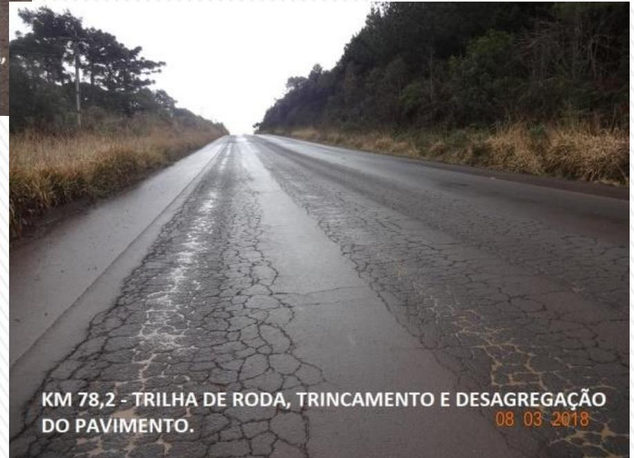
KM 78,2 - TRILHA DE RODA, TRINCAMENTO E DESAGREGAÇÃO DO PAVIMENTO. 08 03 2018
