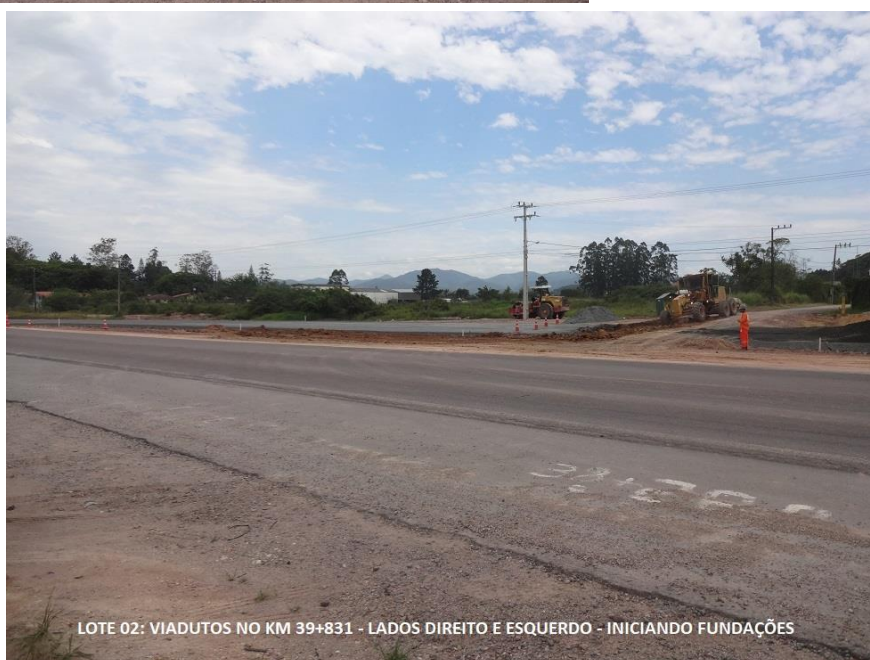
LOTE 02: VIADUTOS DE RETORNO, EM GASPAR. PISTAS DOS LADOS ESQUERDO E DIREITO
