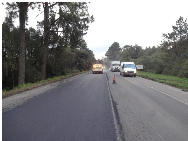
Ilustração 30: Pista restaurada no km 221,5
