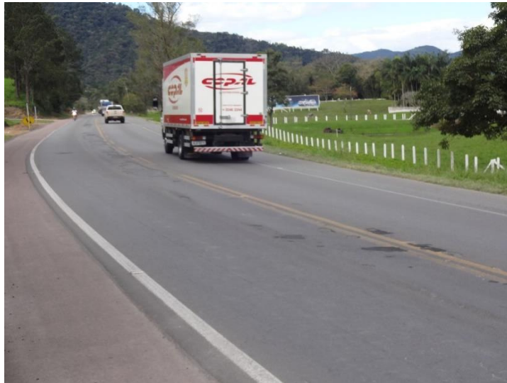
Ilustração 22: Trilha de roda e afundamento no km 128
