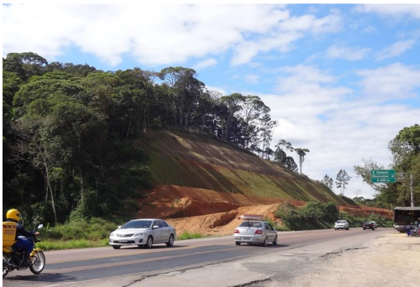
Ilustração 19: Corte e "Caixa de Empréstimo" do lote 03
