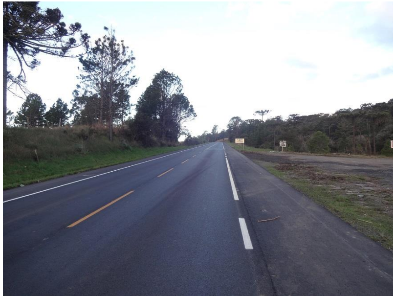
Ilustração 31: Observa-se plataforma restaurada e sinalizada
