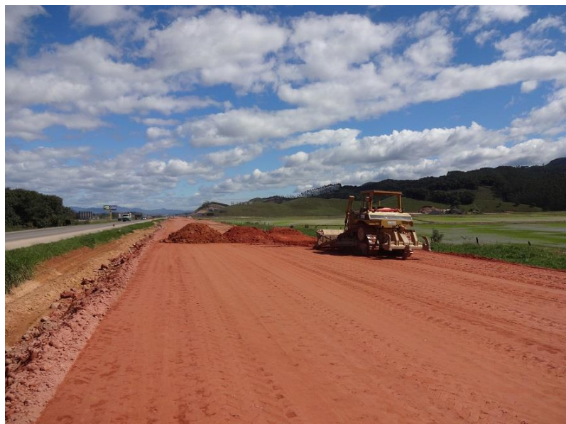
Ilustração 10: Segmento com terraplenagem em fase de conclusão
