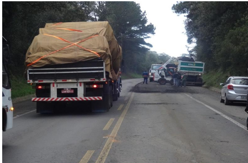
Ilustração 29: Obras de restauração de pista entre km 213,5 e 223
