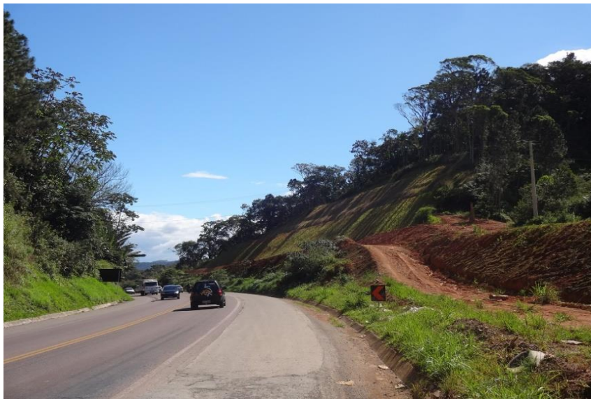
Ilustração 18: Alargamento no km 51,0 - Corte e enleivamento parcialmente executado
