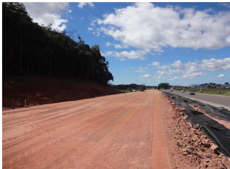
Ilustração 13: Uso de consolidação profunda radial para estabilização do solo de fundação antes da execução de terra armada, nas interseções
