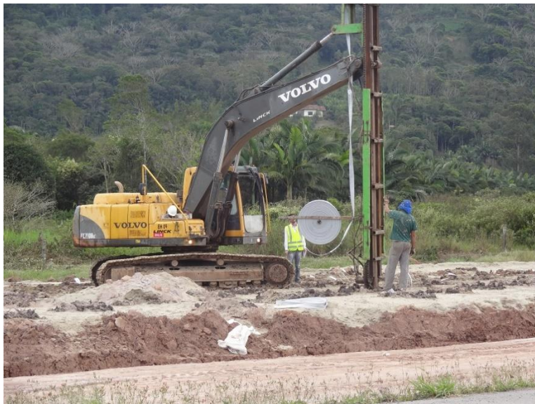
Ilustração 2: No segmento entre os km 2,0 e 3,9 - Execução de geodrenos verticais
