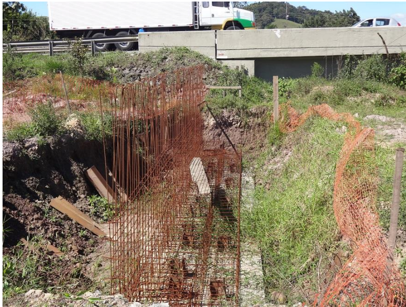
Ilustração 7: Fundações da nova Ponte sobre o Rio Luiz Alves
