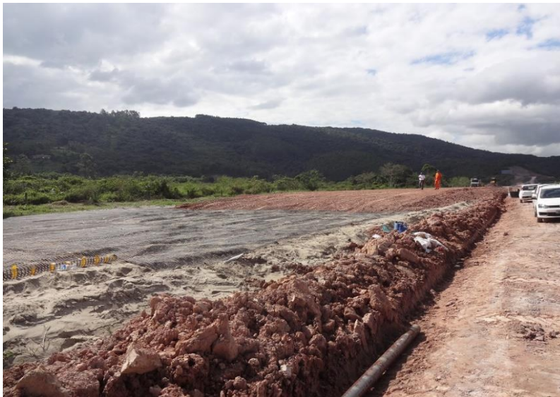
Ilustração 5: Obras de acabamento da implantação sobre solos moles
