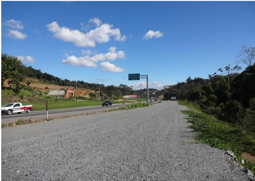
Ilustração 17: Km 48,5 - Pavimento parcialmente executado
