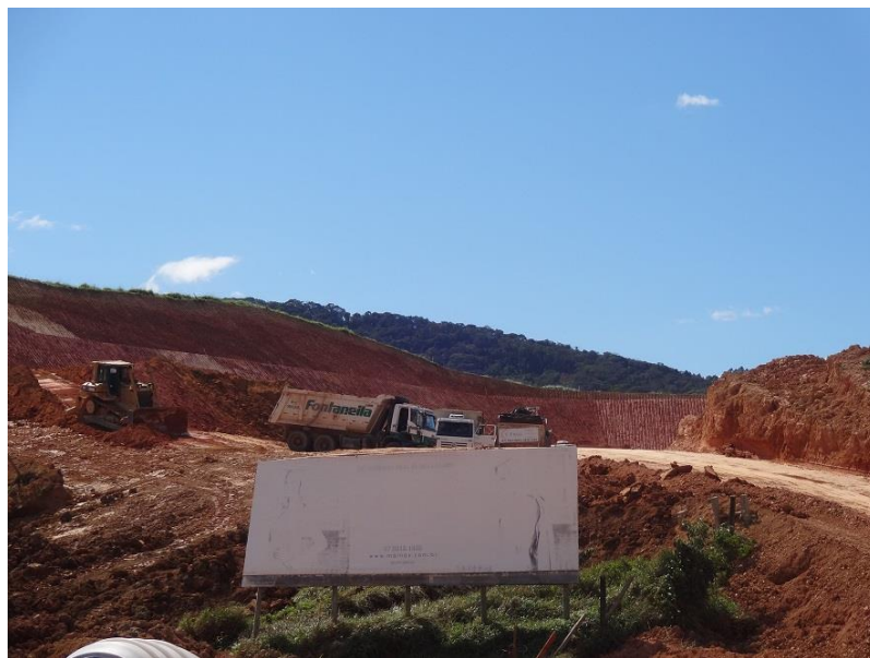
Ilustração 9: "Caixa de empréstimo" - Materiais de aterro
