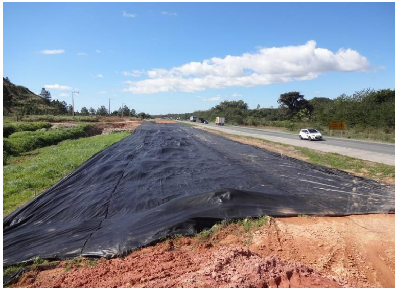
Ilustração 8: Colocação de geotêxtil, antes da terraplenagem
