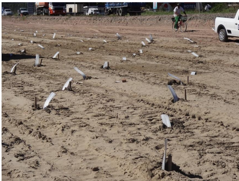
Ilustração 3: Geodrenos verticais executados em camadas de solos moles
