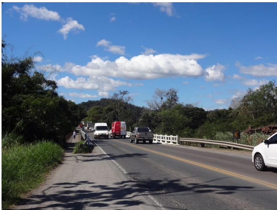
Ilustração 21: Trincamento e desagregação do pavimento no km 82,3
