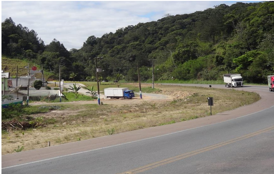
Ilustração 20: Terraplenagem de alargamento de pista no km 49,2
