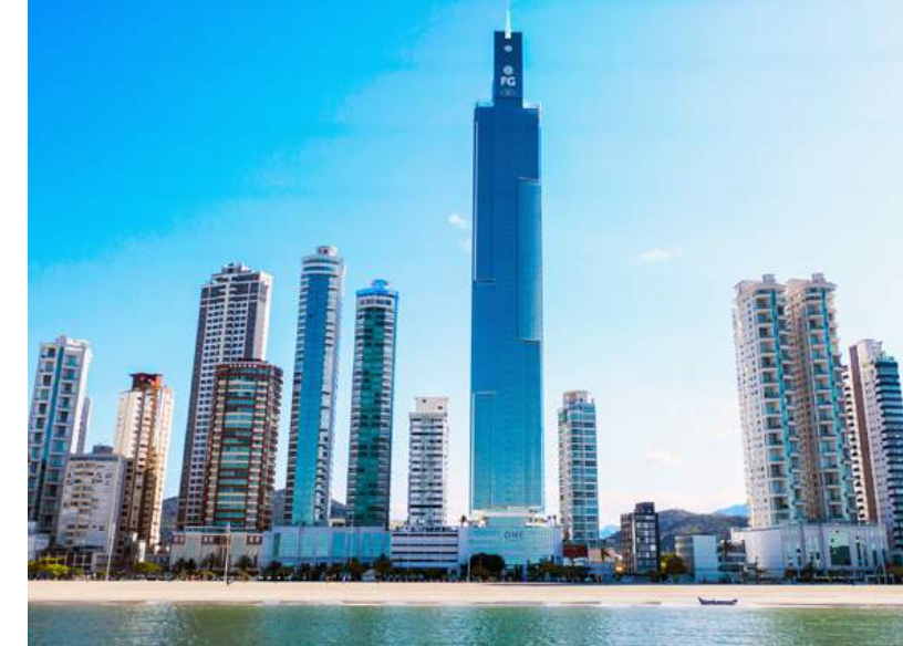
One Tower, de 84 andares, demandou mais de 9 mil toneladas de aço na construção
