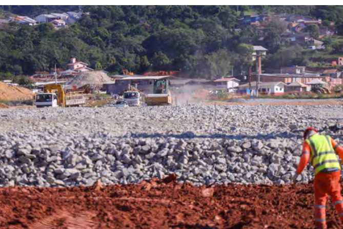
Com a conclusão da obra, 22 mil veículos pesados passarão pelo Contorno por dia
