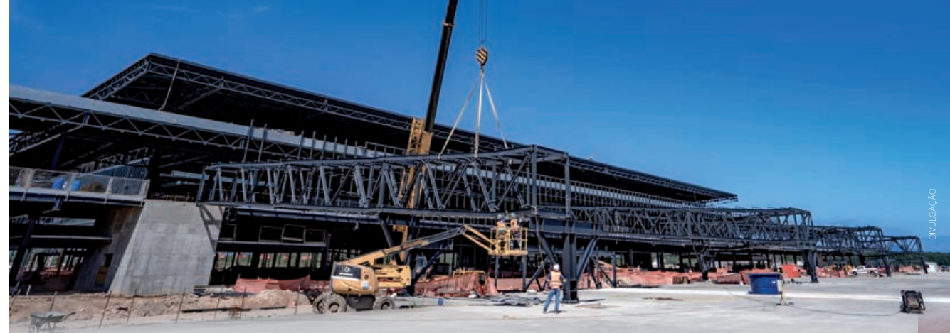
Construção do novo terminal do aeroporto de Florianópolis: obras de acesso estão atrasadas
