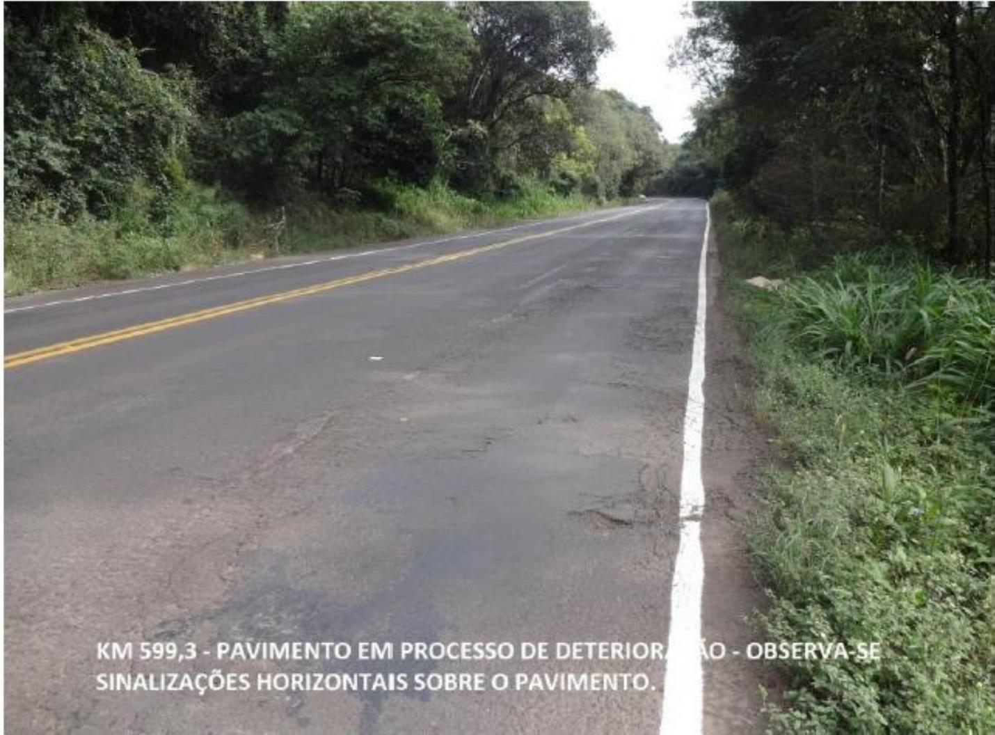
KM 599,3 - PAVIMENTO EM PROCESSO DE DETERIORAÇÃO - OBSERVA-SE SINALIZAÇÕES HORIZONTAIS SOBRE O PAVIMENTO.
