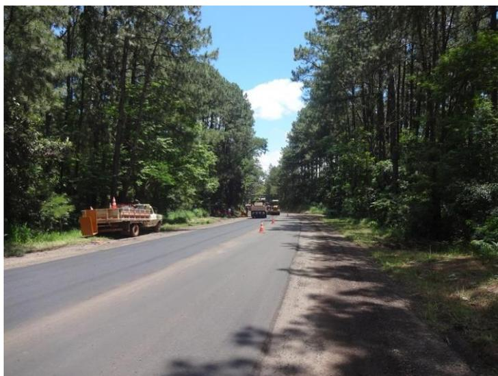
Figura 9: Km 611,8 - Recomposição da capa asfáltica com mistura betuminosa usinada quente (MBUQ)
