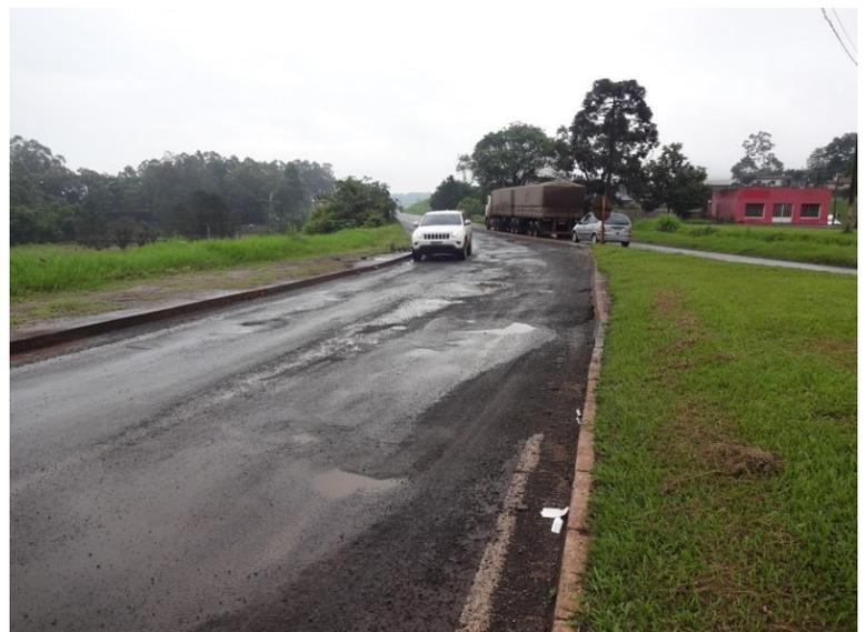
Figura 4: Trevo de acesso a Pinhalzinho (km 581)- Afundamentos e recalques do pavimento
