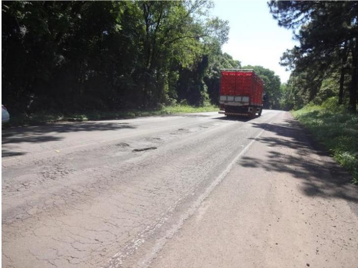
Figura 2: Km 594,5 - Trilha de roda e afundamento da pista
