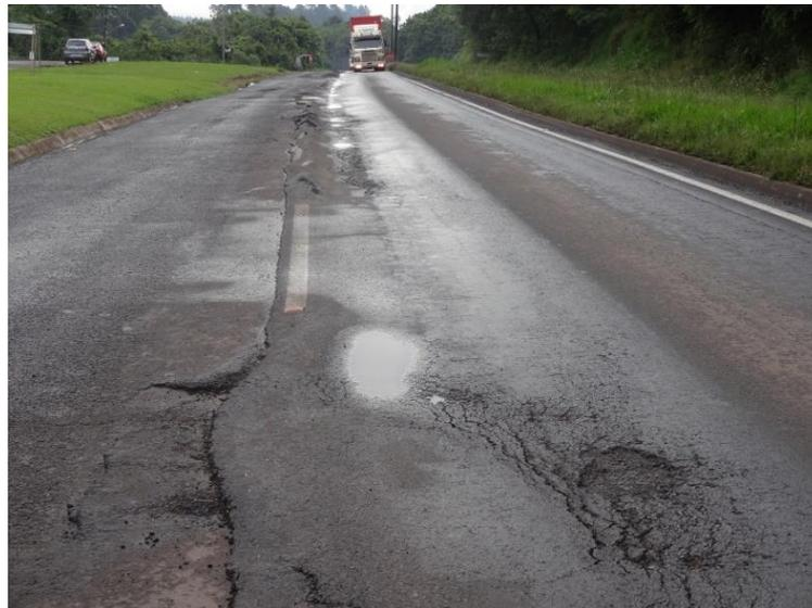
Figura 6: Nova Itaberaba - km 555,6 – Trincamento / desagregação e afundamento do pavimento
