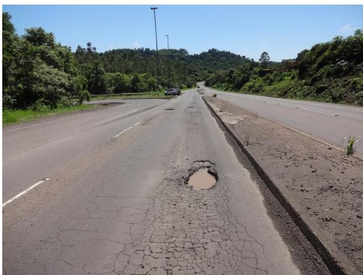
Figura 16: Acesso a Caibí - Buracos, trincamento e deformações do pavimento
