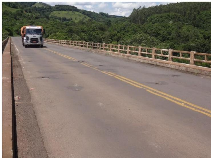
Figura 3: Situação da capa asfáltica na Ponte sobre o Rio das Antas (km 628,7)
