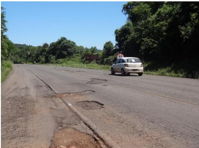
Figura 15: Km 132,8 - Situação do revestimento asfáltico da pista e do acostamento
