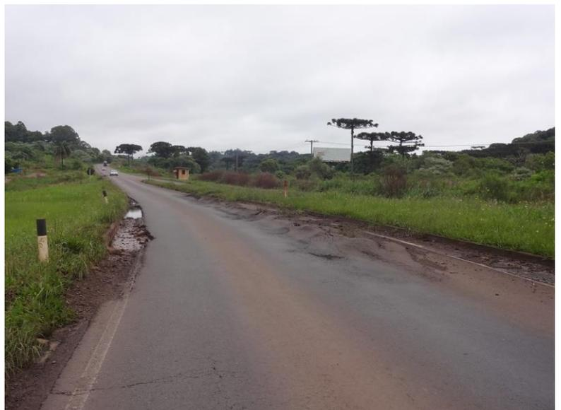
Figura 7: Km 515,3 - Afundamento e recalque do pavimento
