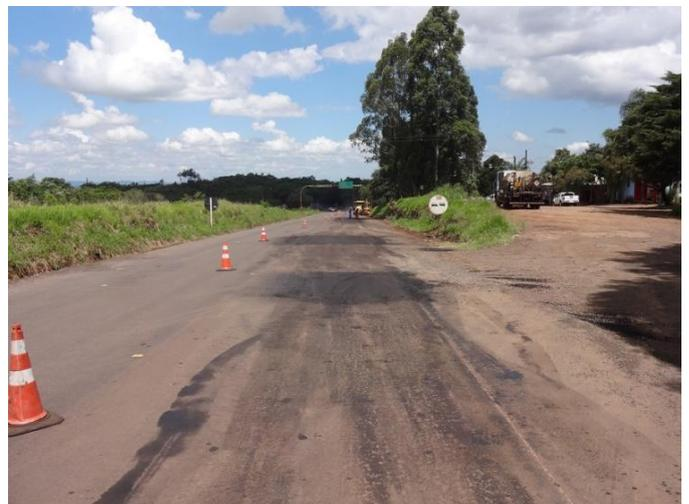
Figura 12: Execuções de drenagens profundas e recomposição do revestimento no km 644,5 (Próximo acesso BR-163.SC)
