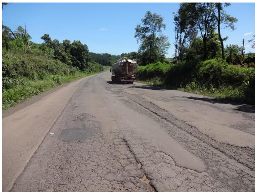
Figura 14: BR-158/SC , km 132,1 - Desagregação e trincamento do pavimento
