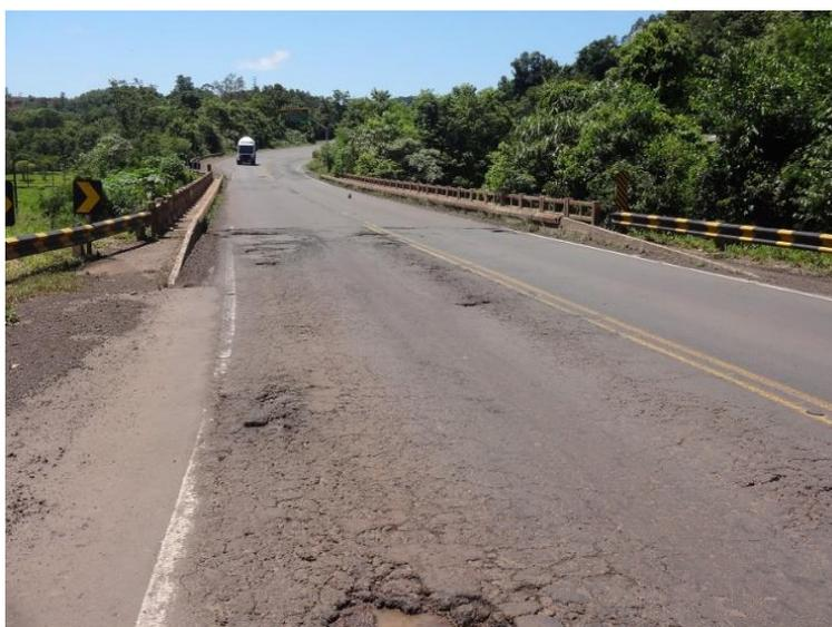
Figura 17: Ponte sobre o Rio São Domingos (km 134,3)- Buracos e afundamento do pavimento na cabeceira
